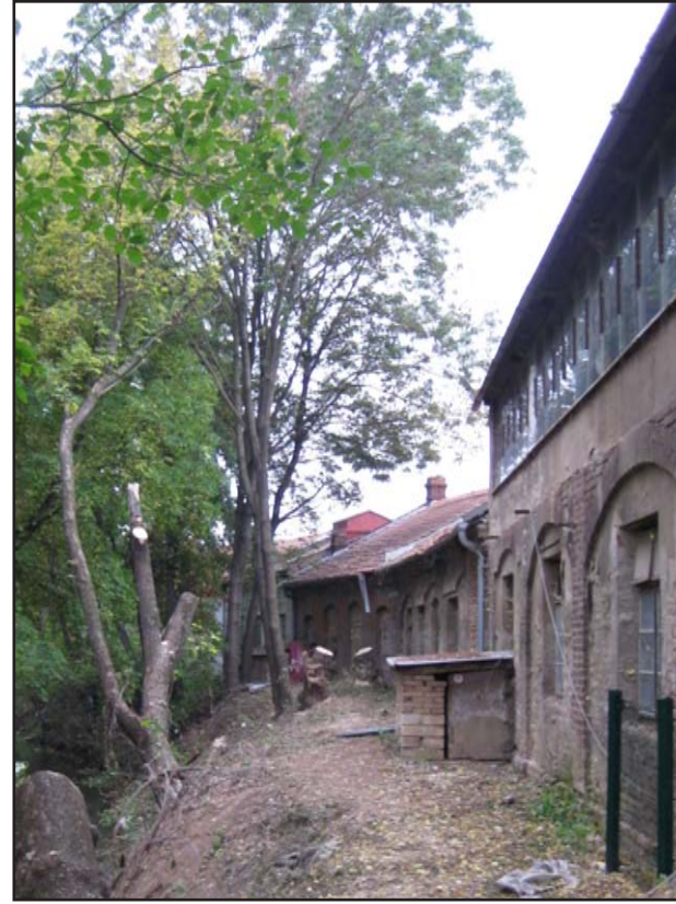
32 ZA AREÁLEM NA ULICI DORNYCH Nevhodný a neodborný ořez korun stromů.
