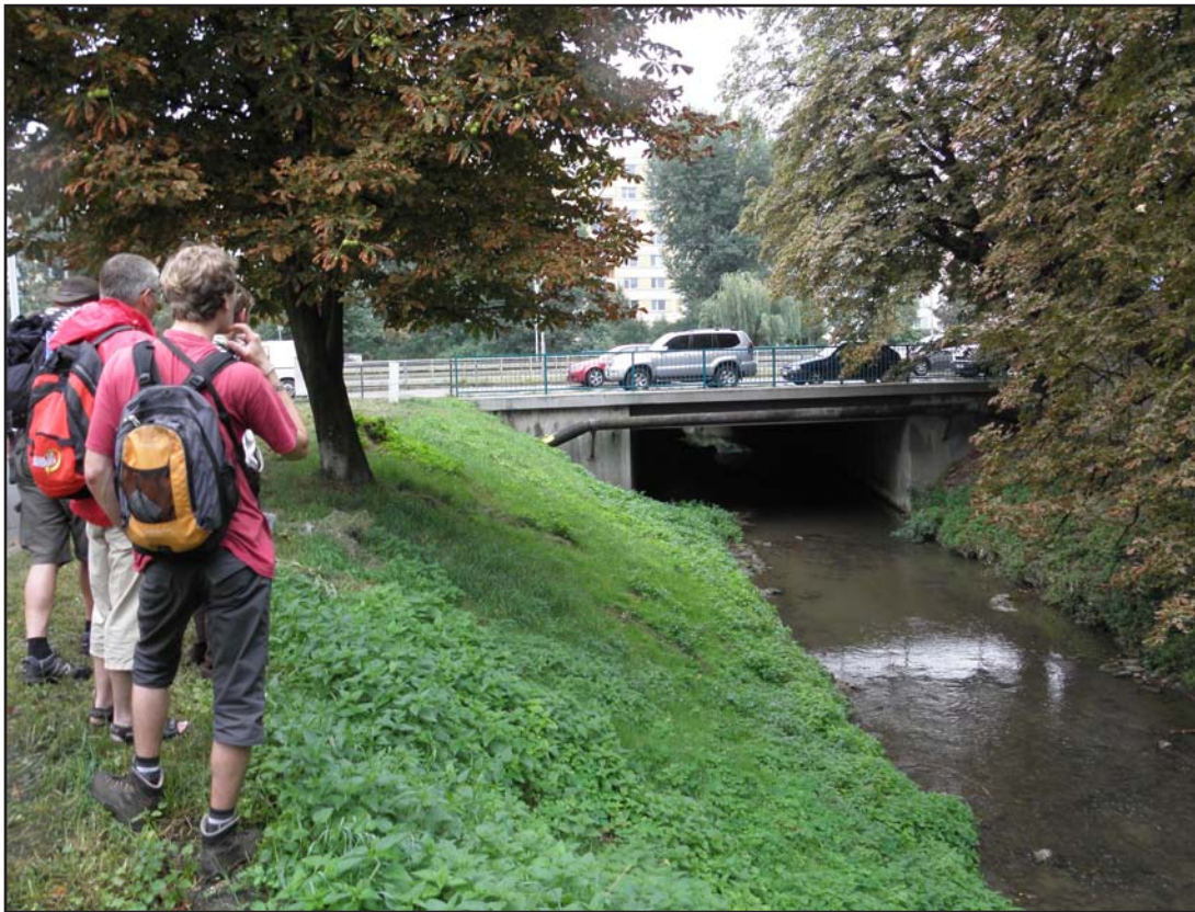
41 MOST PŘES PONÁVKU - ULICE SVATOPETRSKÁ - POHLED Z ULICE KONOPNÉ Patrný nízký a úzký profil pro podchod cyklostezky souběžně s tokem.
