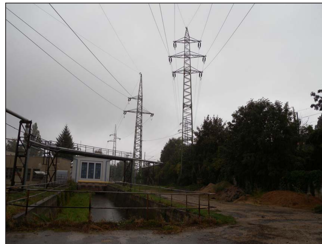
8 TECHNICKÁ INFRASTRUKTURA V areálu Tepláren - nadzemní VVN vedení, vlevo dole objekt regulační stanice plynu. Limit ve využití území.
