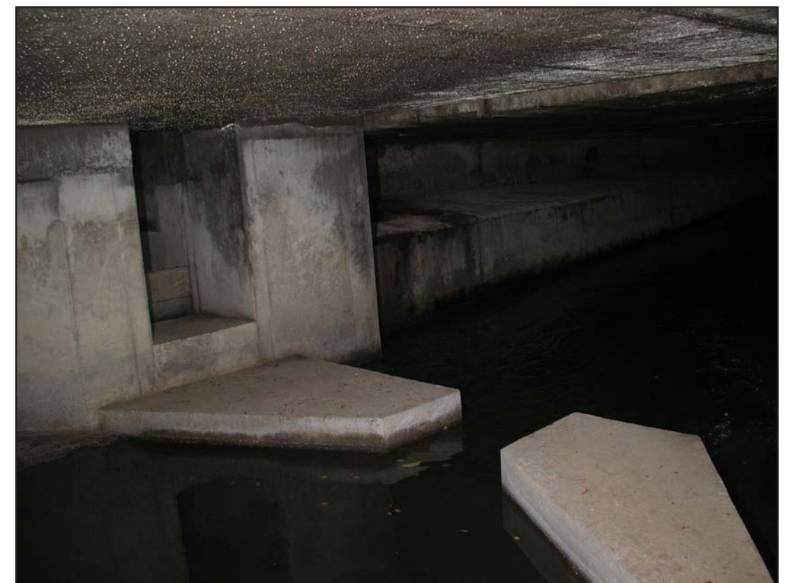
16 VNITŘNÍ PROSTOR ODLEHČOVACÍ KOMORY VLEHÁ. V tomto místě z komory vytéká voda Svitavského náhonu do zaklenutí pod ulicí Křenovou.
