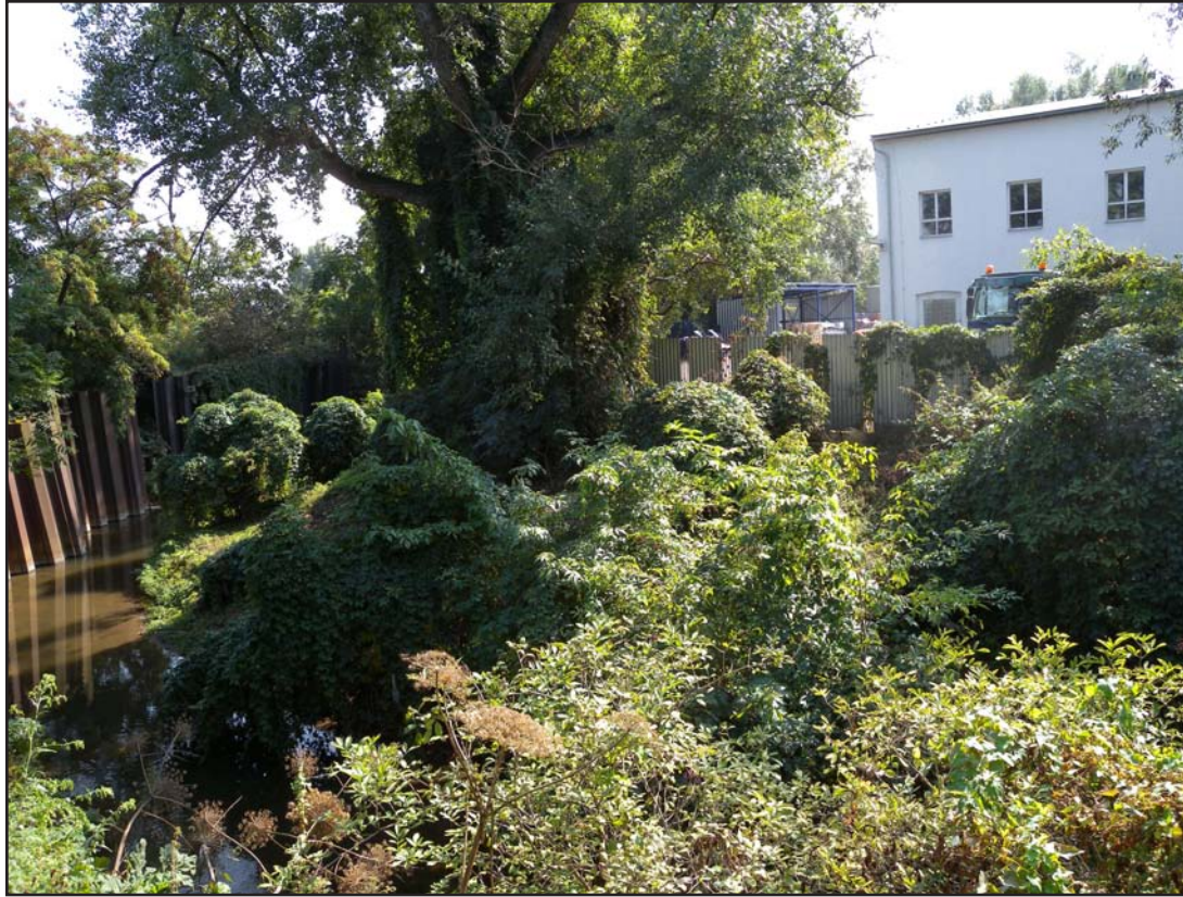
31 RUDERÁLNÍ POROST ZA ŠKOBÁRNAMI Hojné rozšíření popínavých dřevin, vlevo netradiční užití ocelových opěrných zdí.
