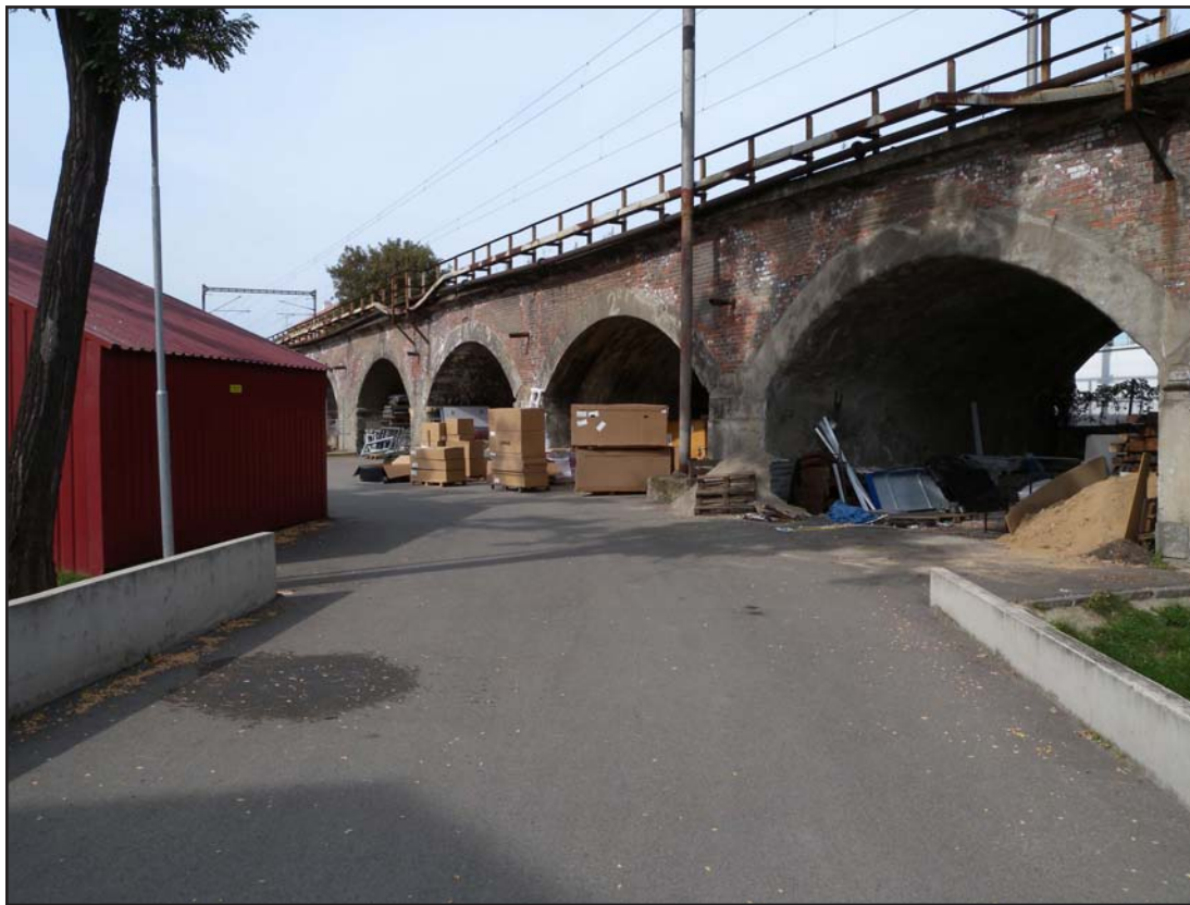
11 MOSILANA - VIADUKT ŽELEZNICE Hodnotný viadukt na Třebovské trati prochází napříč řešeným územím. Po realizaci ŽUB by měl být zrušen a nahrazen komunikací.
