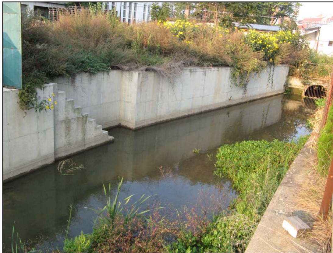
5 POLYMER INSTITUT Vtok do dlouhého souvisle zatrubněného úseku mezi ulicemi Tkalcovská a Radlas.
