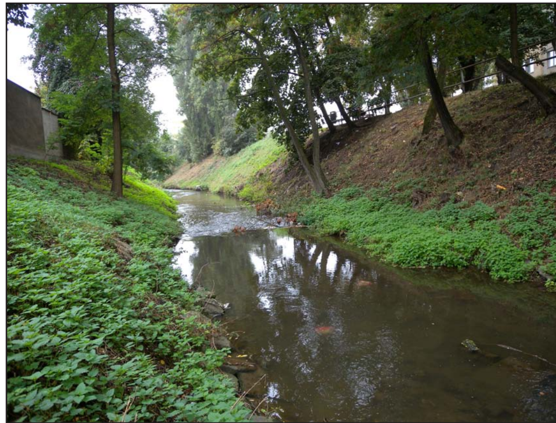
42 NEOPEVNĚNÉ BŘEHY STARÉ PONÁVKY NAD ÚSTÍM DO SVRATKY Patrná hluboká kineta toku pod úrovní okolního terénu.
