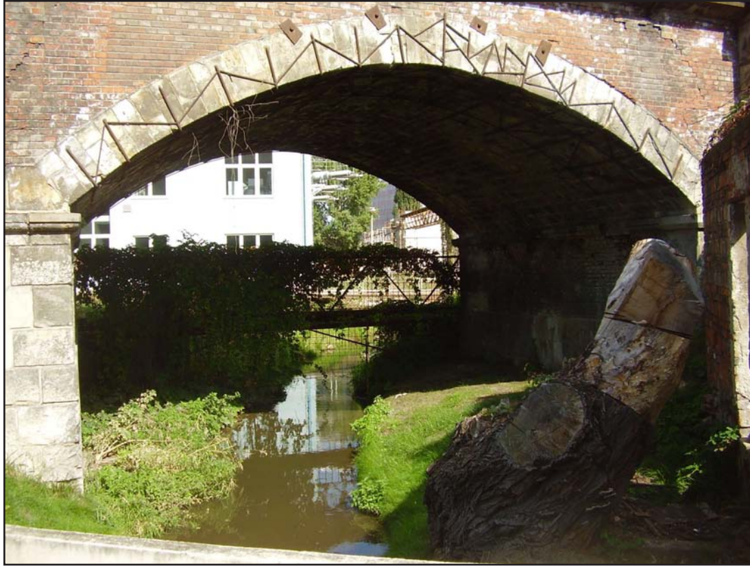
9 MEZI TEPLÁRNAMI A BÝV. MOSILANOU Koryto Svitavského náhonu protéká pod obloukem železničního viaduktu.
