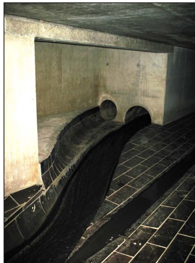
15 VNITŘNÍ PROSTOR ODLEHČOVACÍ KOMORY VLEHÁ. Těmito dvěma kruhovými profily je vedena voda Svitavského náhonu. Shybka je vyústěna do vnitřního prostoru objektu.
