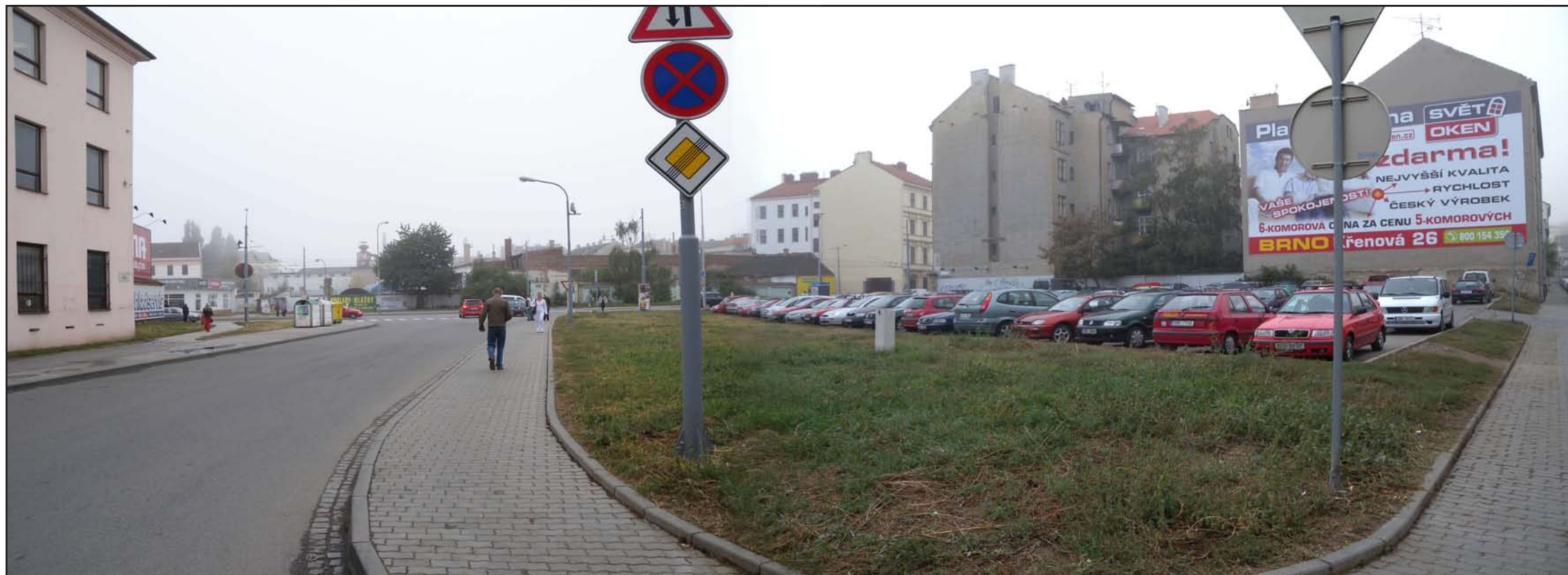
19 PLOCHA MEZI ULICÍ KŘENOVÁ A SKOŘEPOVA V současné době využíváno jako parkoviště. Vlevo dole pod komunikací je situována odlehčovací komora Vlhká.
