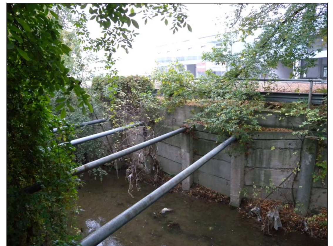
30 PAŽENÍ OPĚRNÝCH ZDÍ V části nevyužívaného areálu Škrobáren. Takto podobně vypadalo koryto před úpravou.
